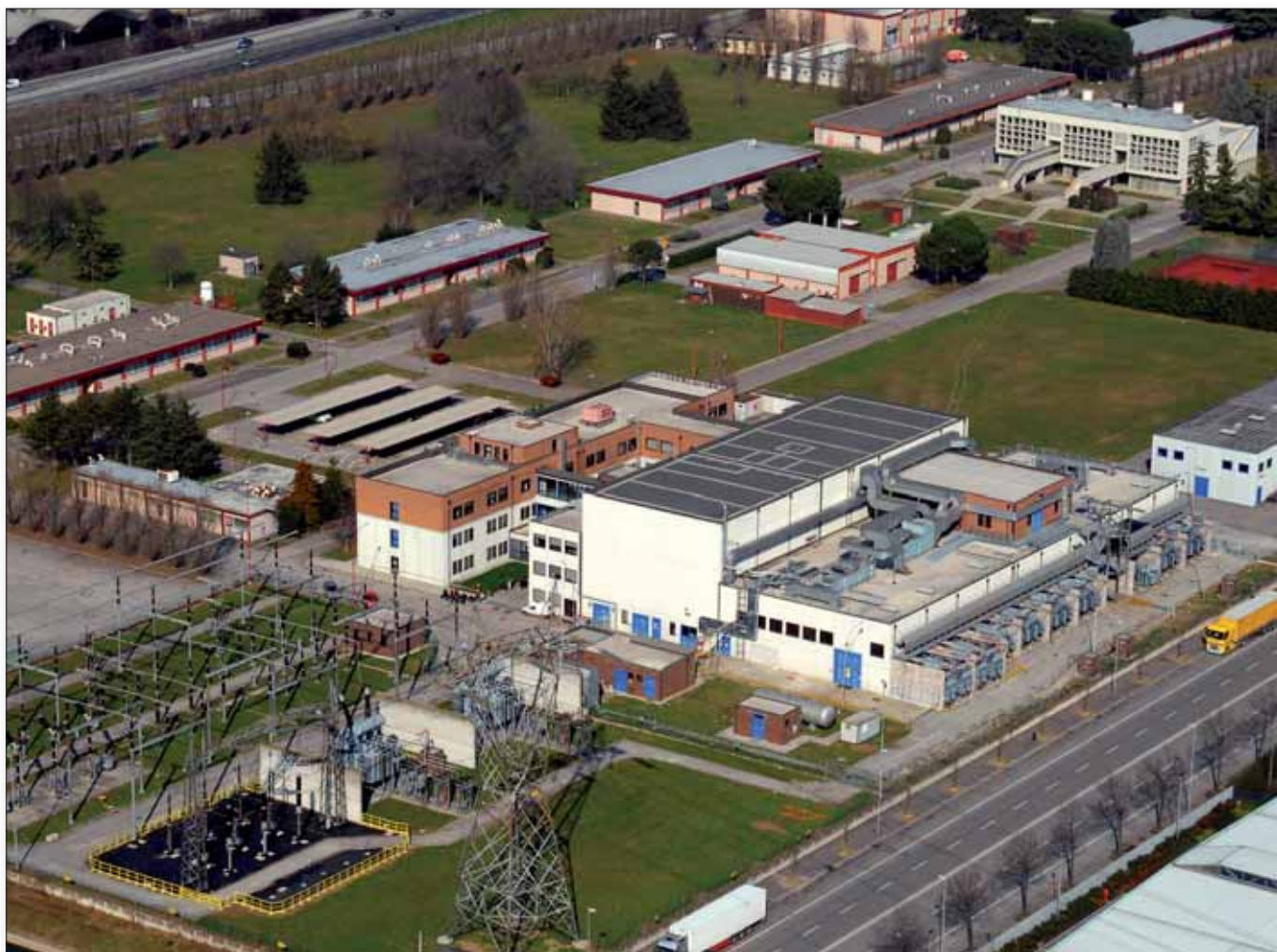
Fig. 1.5 Foto aerea degli edifici che ospitano l'esperimento RFX, situato all'interno dell'Area di Ricerca del CNR di Padova
